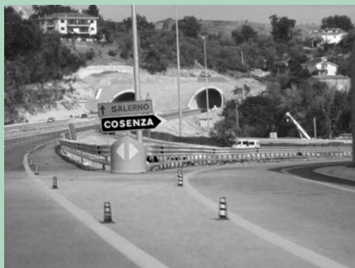
Una delle interruzioni dell'autostrada A3 prima del completamento [Uscita Cosenza]
